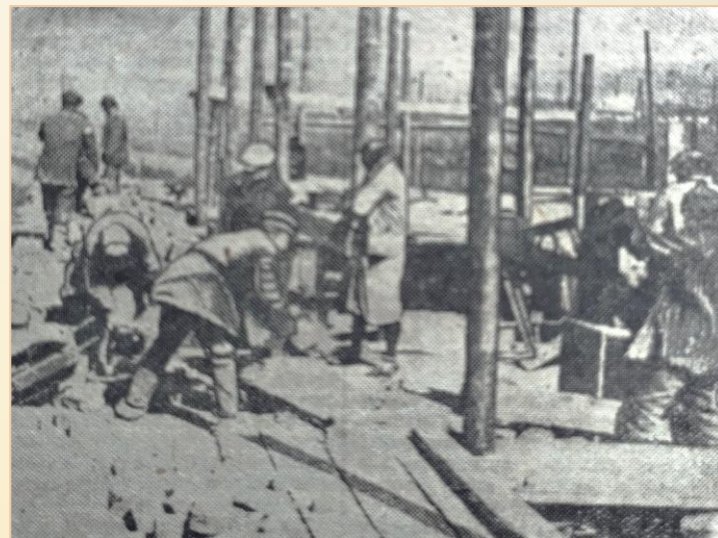
Бригада на кладке стен
