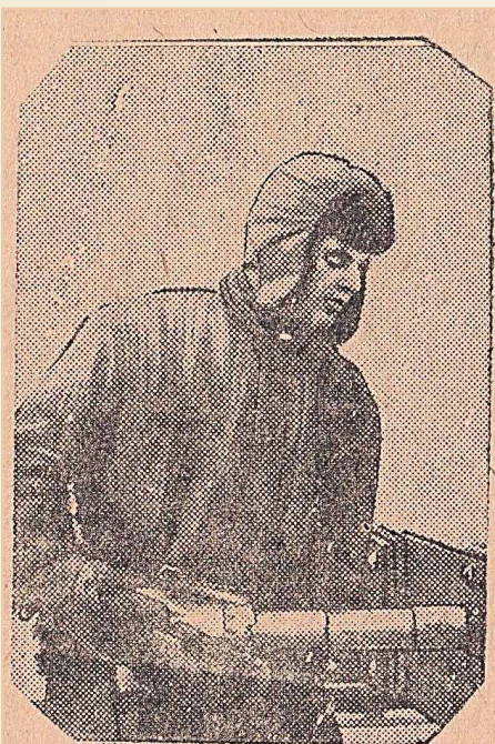
Стахановец Деревенчук, клепальщик цеха металлоконструкций,
